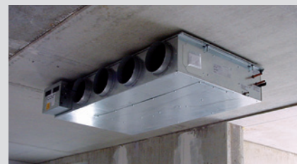
Die Colt-Caloris® Wärmepumpen werden im Zwischendeckenbereich jeder Etage montiert – Kühlen und Heizen durch Wärmepumpentechnologie mit einem unisolierten kältemittelfreien Zweirohrsystem im Ganzjahresbetrieb
